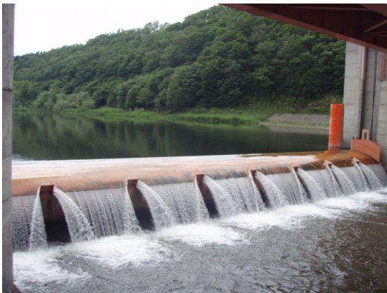
真敷別頭首工
