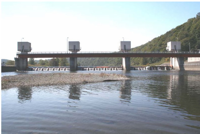
真敷別頭首工
