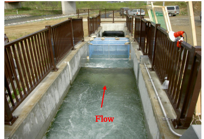
魚道部トラップ調査状況
