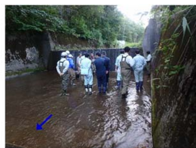
朝日六線川(4号床固工) 魚道整備に向けた設計協議
