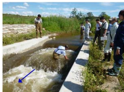
コクネップ川魚道の流況等確認（No4 落差工魚道）
