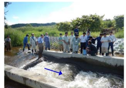
コクネップ川魚道の現地確認（No5 落差工魚道）
