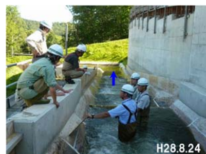
[試験階段式魚道] 流況確認
