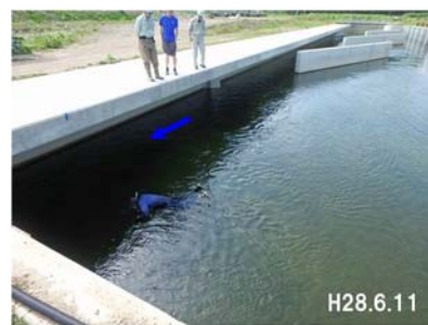
[本川との接続箇所] 施設内の流況確認
