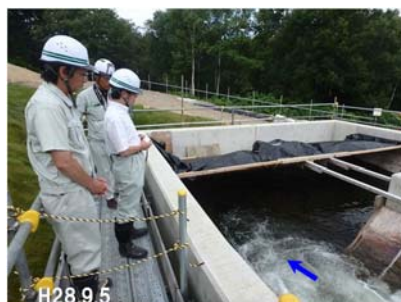
[試験階段式魚道] 流況確認
