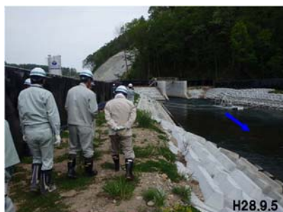
[仮排水路] スモルトの降下状況確認
