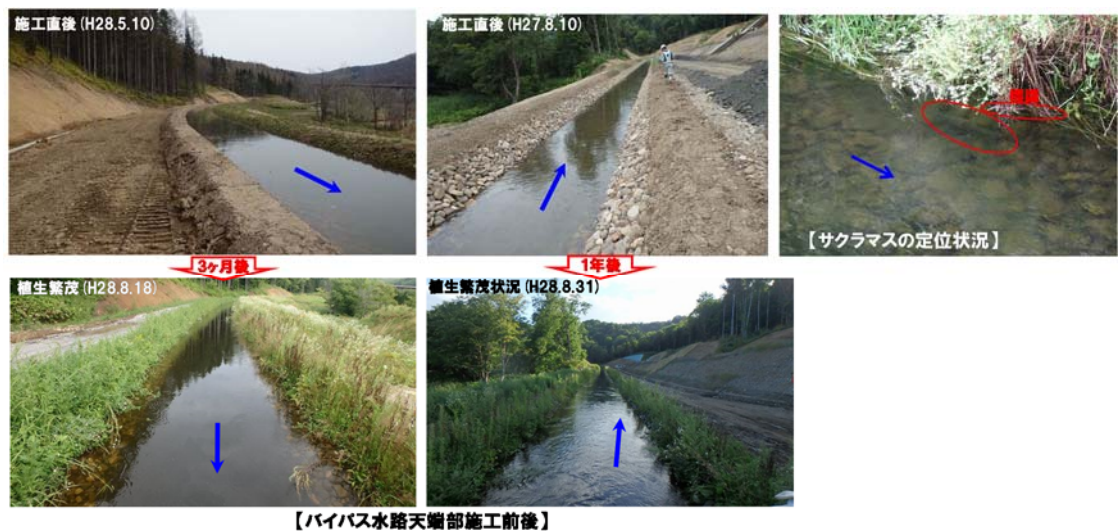
写真- 16 バイパス水路天端部の水際植生の繁茂状況（施工直後と3ヶ月以降）
