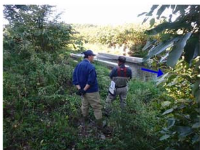
九線(南8線)川(No.1 落差工) 魚道の現地確認
