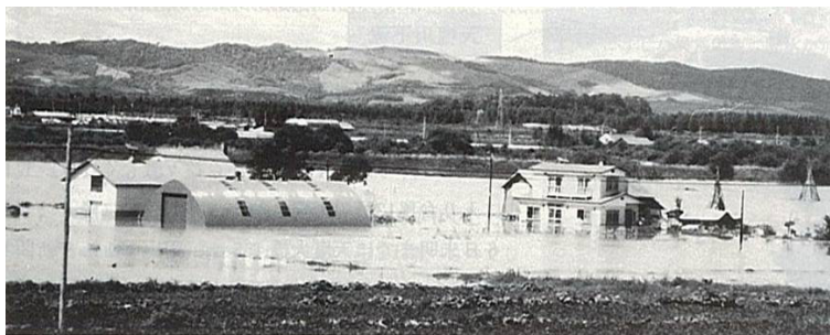
天塩川左支川剣淵川 剣淵町地内の氾濫
