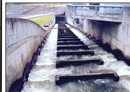
アメリカコロンビア川の ボンビレーダムにおける 階段式魚道
