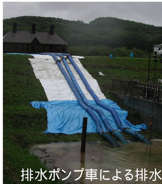
排水ポンプ車による排水
