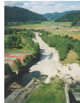
岩尾内ダム直下 無水時
