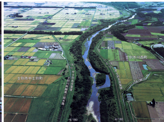
周辺樹林地と連続した状況
