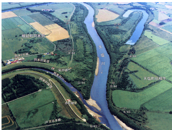
支川及び旧川と連続した状況
