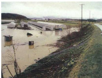
名寄川上名寄16線樋門地先浸水状況 平成18年5月11日午前撮影
