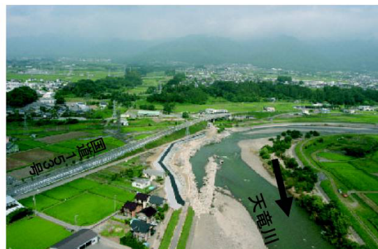
応急復旧及び緊急復旧の完成
