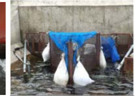
② ペンケニウブ川取水堰 魚道トラップ設置状況 (魚道上流側入口)
