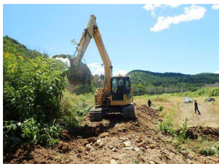
重機によるオオハンゴウソウの掘り取り
