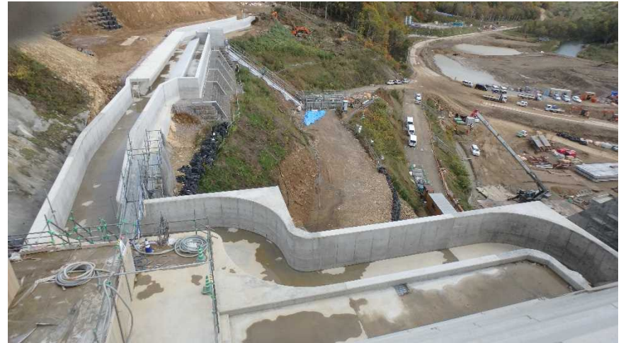
余水吐き施工状況（H29. 10）
