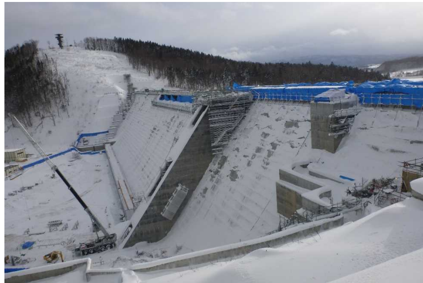
ダムサイト右岸上流より（H29. 12）
