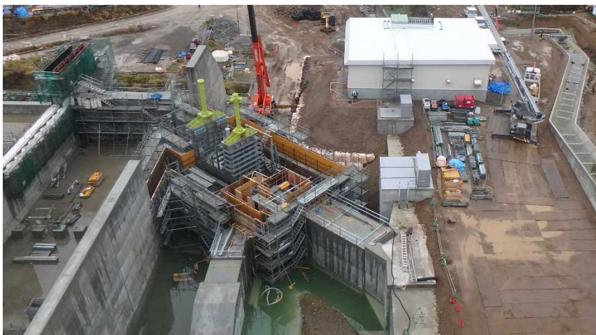
放流設備・発電所施工状況（H29. 10）
