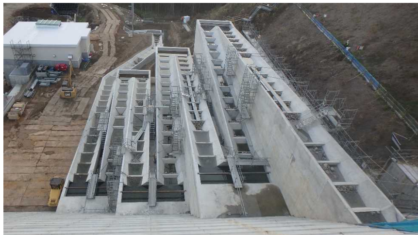
堤体付魚道全景（H29. 10）
