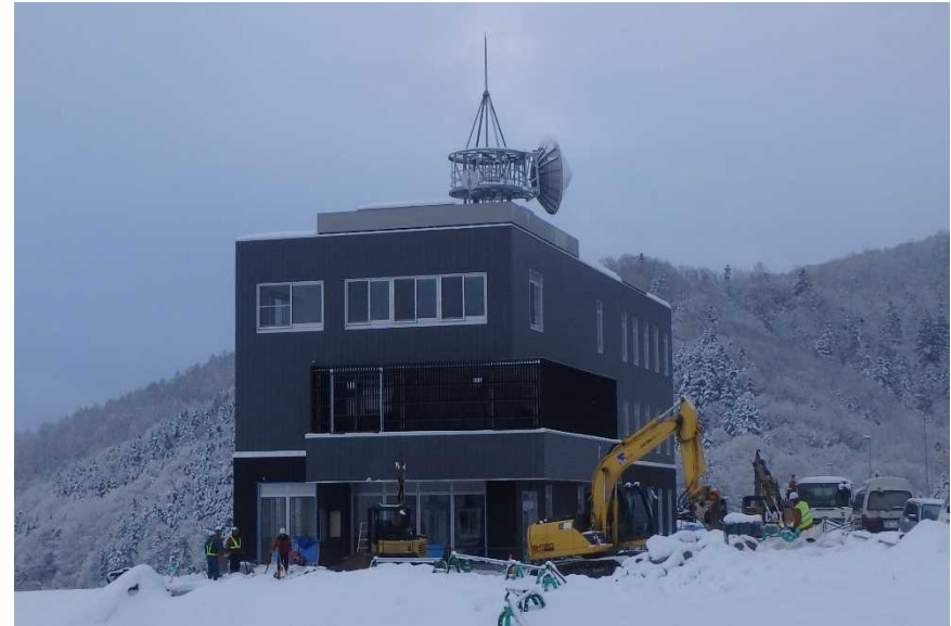
管理棟施工状況（H30. 1）
