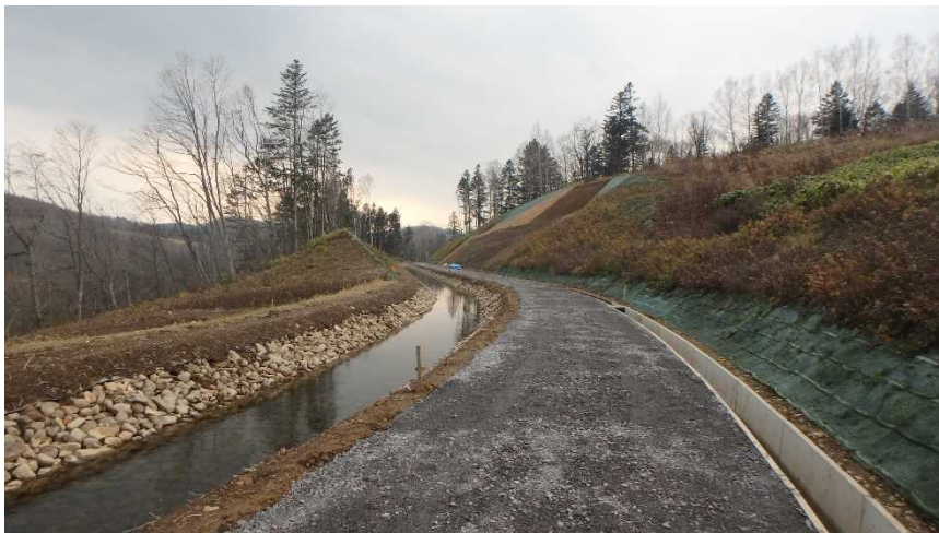
湖岸管理用道路・バイパス水路（H29. 11）
