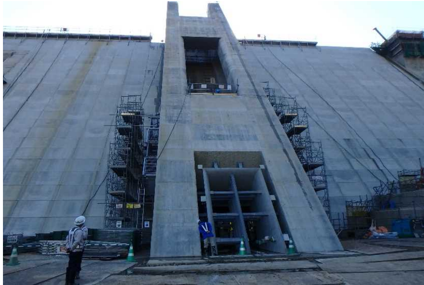
取水設備施工状況（H29. 10）
