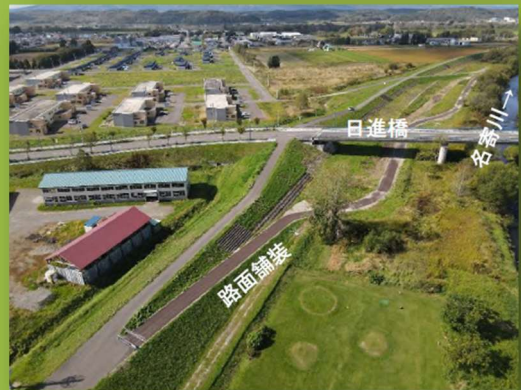
路面舗装の整備状況
