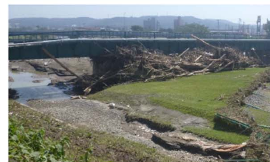
流木による断面阻害状況 (久慈川)
