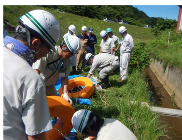
排水ポンプ設置作業
