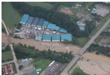
多量の土砂流入状況 (ペケレベツ川)
