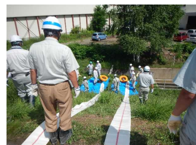
排水ポンプ設置状況
