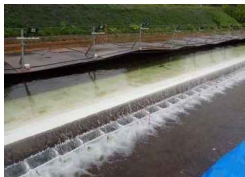
余水吐調査状況
