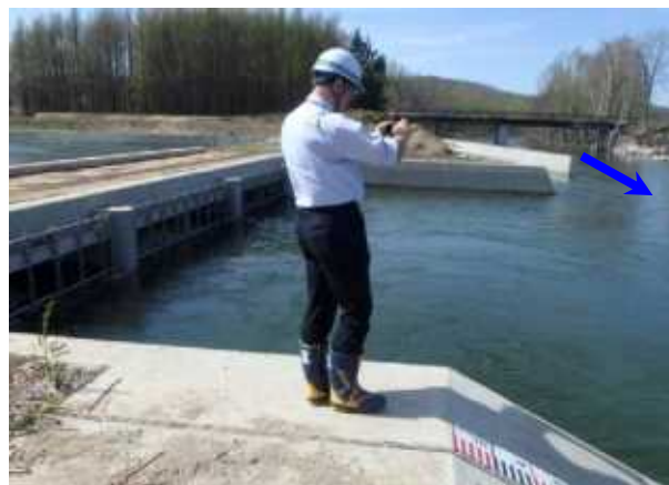
(5/10 本川との接続箇所) 施設流入部状況確認
