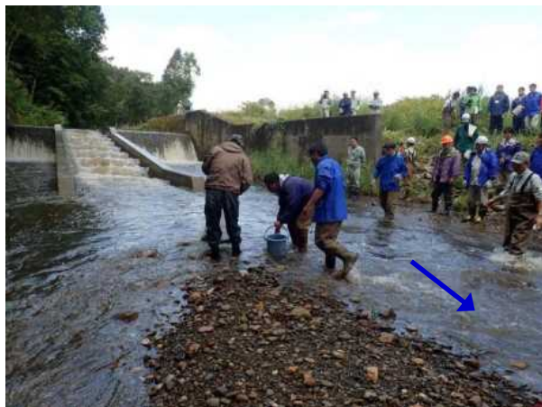
有利里川(第4号頭首工) 魚道の流況・生息魚類確認
