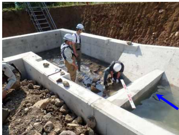
(8/25 階段式魚道) 折返し部石組み指導
