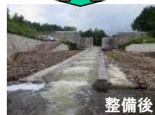
新生川 2号砂防えん堤 魚道新設 (H29.8)
