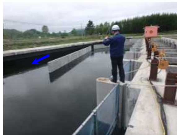
(5/24 本川との接続箇所) 流況確認
