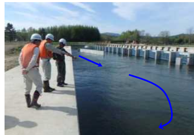
(5/19 本川との接続箇所) 流況確認
