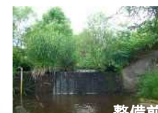
パンケウブシ川 6号落差工 魚道新設 (H30.3)
