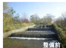
三十号川 1号落差工魚道新設 (H30.3)
