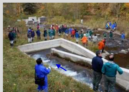
魚道と河道接続部の 現地確認状況
