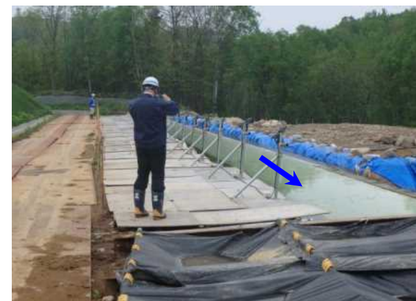
(5/23 バイパス水路・試験余水吐) スモルト降下状況確認
