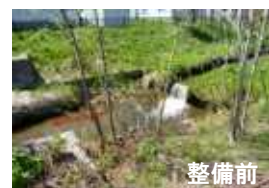
パンケウブシ川 床止工魚道新設 (H30.3)
