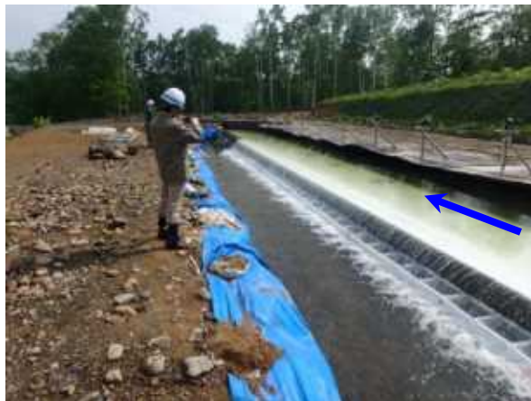
(5/31バイパス水路・試験余水吐) スモルト降下状況確認
