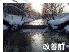
有利里川 第1号落差工 魚道新設 (H30.3)
