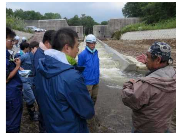
新生川(2号砂防えん堤) 魚道の機能確認・指導
