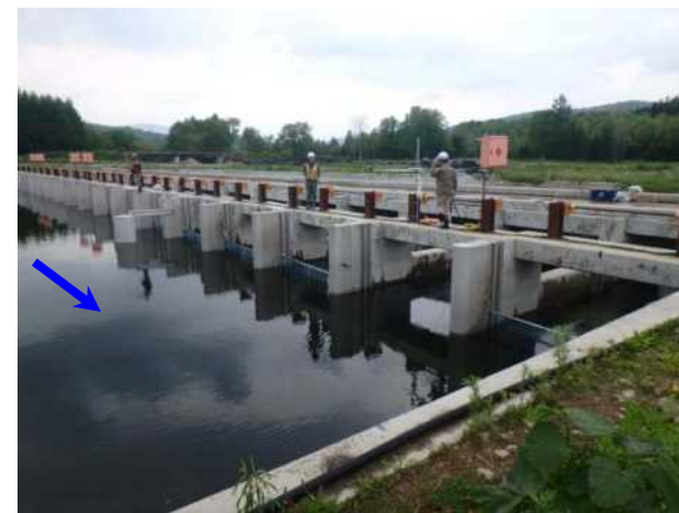
(5/31 本川との接続箇所) スモルト降下状況確認
