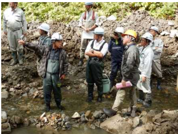
アラキの川 (No3床固工魚道) 魚道・河道整備に対する指導
