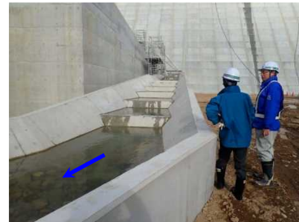
(10/25階段式魚道) 施設確認
