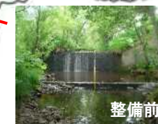
パンケウブシ川 7号落差工 魚道新設 (H30.3)
