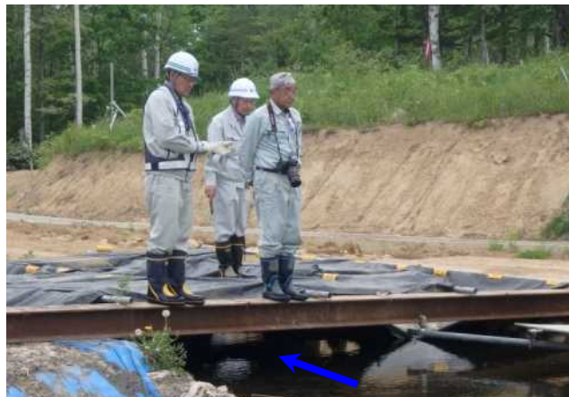
(6/11 バイパス水路・試験余水吐) スモルト降下状況確認
