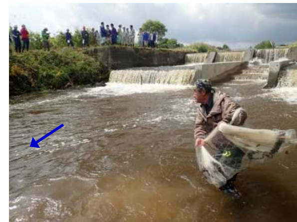
有利里川(第3号頭首工) 魚道の流況・生息魚類確認
