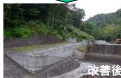
アラキの川 No3床固工 魚道新設 (H29.9)
