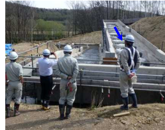
(5/10試験階段式魚道) 通水状況確認
