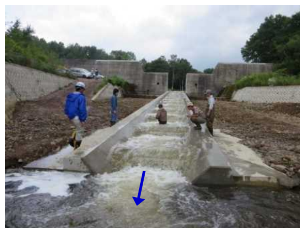
新生川(2号砂防えん堤) 魚道内の流況確認
