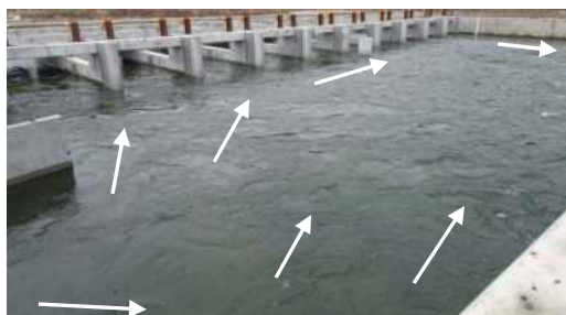
施設内の流況状況確認写真 (27m 3 /s)
