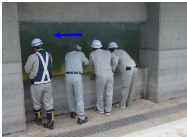
(6/11 本川との接続箇所) スモルト降下状況確認
