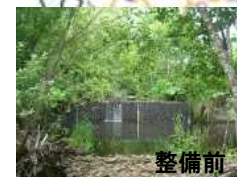
パンケウブシ川 8号落差工 魚道新設 (H30.3)
