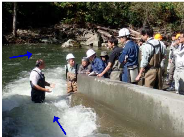
物満内川 (No2床固工魚道増設) 魚道の流況確認
