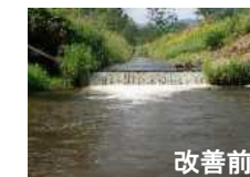
有利里川 第2号落差工 魚道新設 (H30.3)
