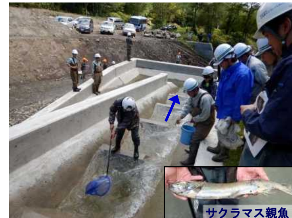
アラキの川 (No3床固工魚道) 魚道の流況・生息魚類確認
