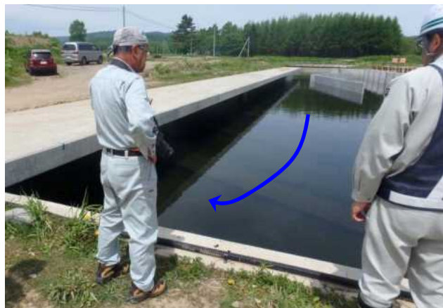
(6/11 本川との接続箇所) 流況確認
