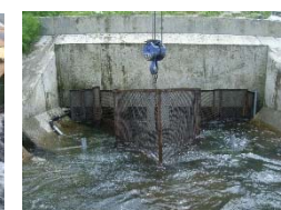
② ペンケニウブ川取水堰 魚道トラップ設置状況 （魚道上流側入口）
