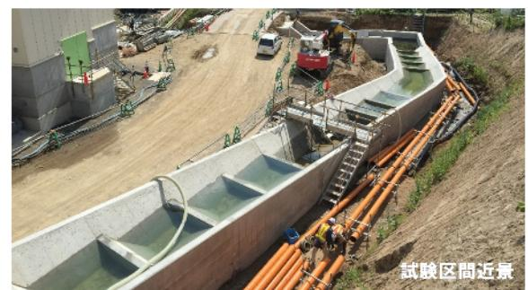
写真- 16 階段式魚道の整備状況
