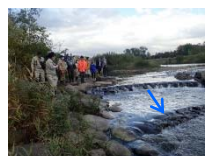
石組み魚道(下流側から)
