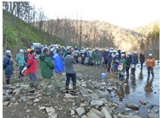
委員による設計・施工の説明
