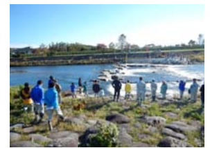
両岸からの魚道現地確認状況
