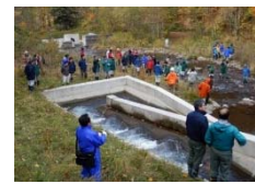
魚道と河道接続部の 現地確認状況
