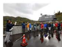
サンルダム魚道施設の概要説明
