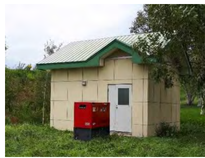
美瑛町給水施設(旭川道路事務所)
