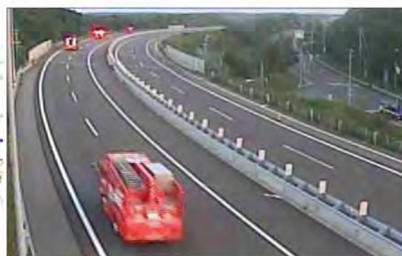
▲緊急車両の通行状況
