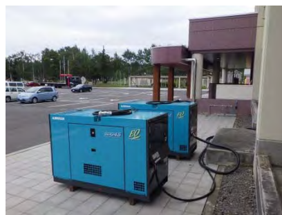
中川町避難所(名寄河川事務所)
