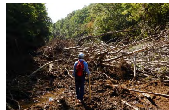
被災状況調査
