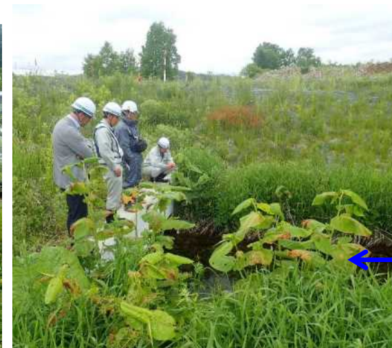
(6/18バイパス水路)流況確認
