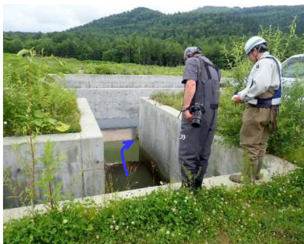
(7/10本川との接続箇所)流況確認
