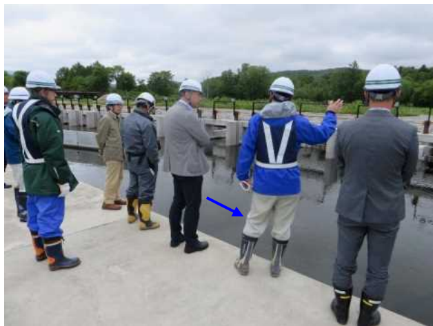
流木除去施設の現地確認
