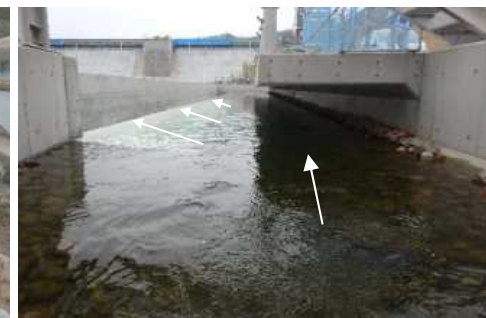
堤体上流余水吐流況
