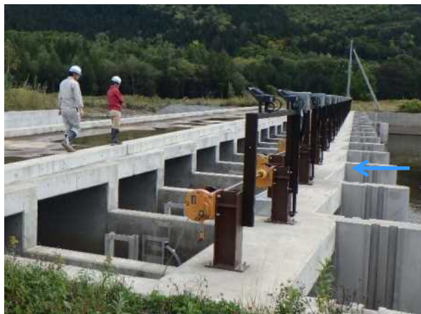
(9/27本川との接続箇所)流況確認
