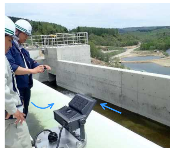
(5/9、5/22堤体上流余水) 流況・スモルト降下状況確認
