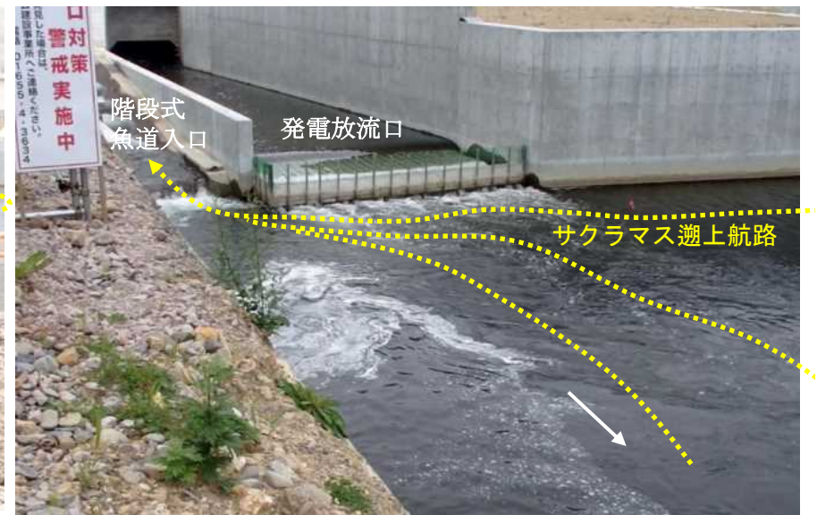
階段式魚道入口部と発電放流口の流況
