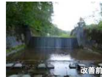
朝日六線川 2号床固工 魚道新設 (H31.3)
