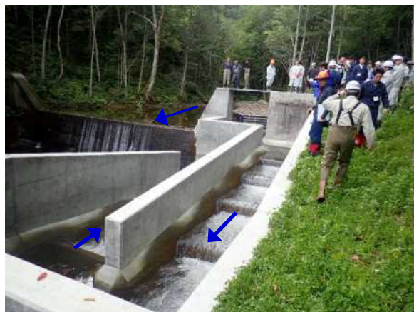
モサナル川 (第1号谷止工魚道) 魚道の流況等確認
