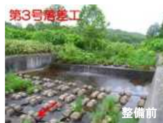
九線川(南8線川) 第3号落差工魚道新設 (H31.3)
