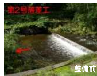
九線川(南8線川) 第2号落差工魚道新設 (H31.3)
