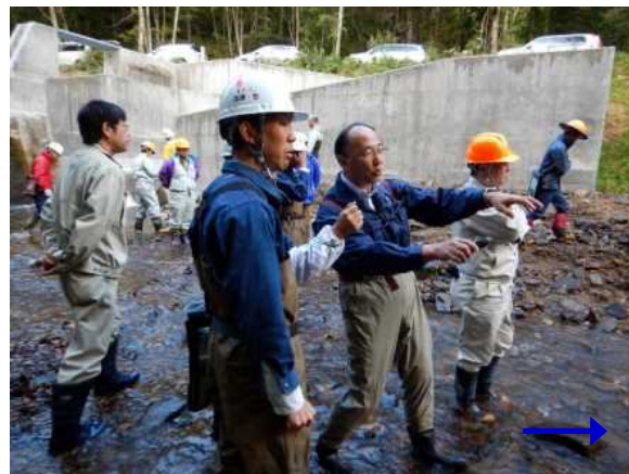
モサナル川 (第1号谷止工魚道) 魚道・河道整備に対する指導状況
