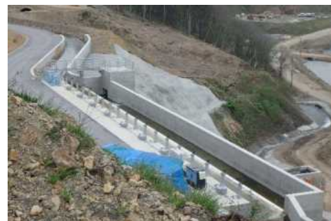
堤体上流余水吐全景
