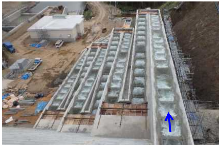
階段式魚道流況全景
