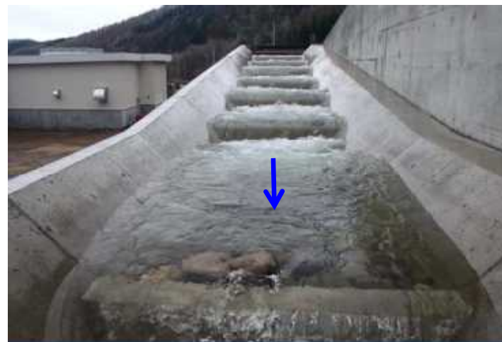
階段部への石材配置状況
