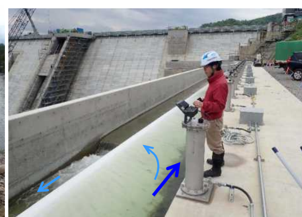
(5/30堤体上流余水吐) 流況・スモルト降下状況確認
