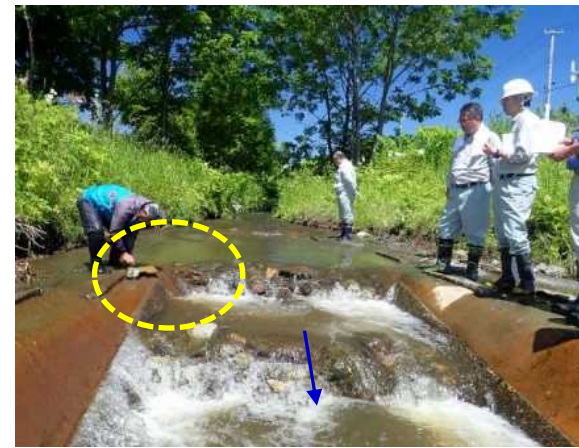
側壁天端石組みによる 遡上経路改善状況の実験
