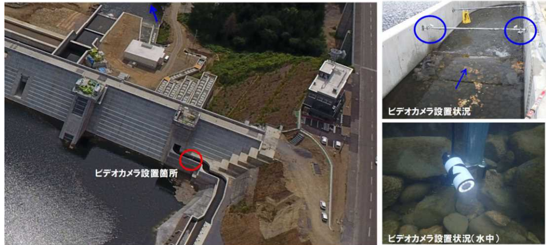
写真- 18 ビデオカメラ設置状況
