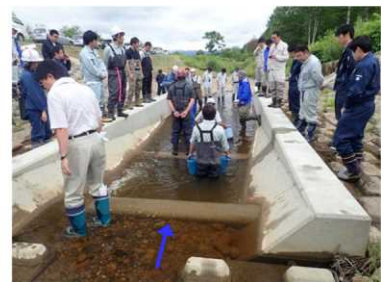
有利里川 (第 2 号落差工魚道) 魚道の評価・改善指導
