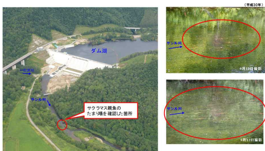
写真- 20 サクラマスの遡上期間中における待機箇所
