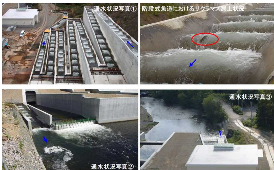
写真- 15 階段式魚道を含む堤体下流部の状況
