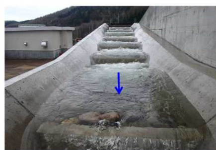
階段部への石材配置状況
