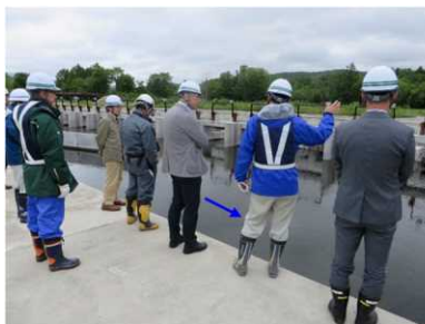
流木除去施設の現地確認
