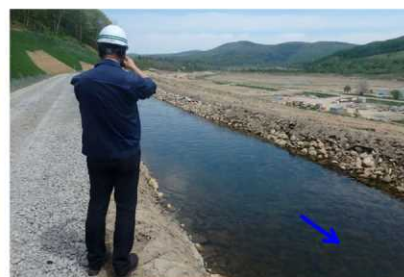
(5/9、5/22バイパス水路) 流況・スモルト降下状況確認
