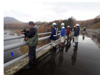
バイパス水路とダム湛水状況 の現地確認
