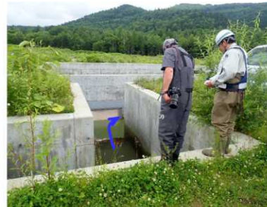
(7/10本川との接続箇所)流況確認
