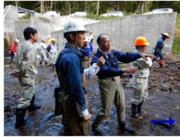
モサナル川(第1号谷止工魚道) 魚道・河道整備に対する指導状況
