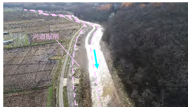
パーパン川 施工済み箇所
