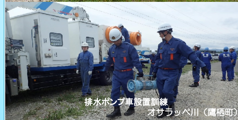
排水ポンプパッケージ設置訓練状況 オサラッペ川（鷹栖町）
