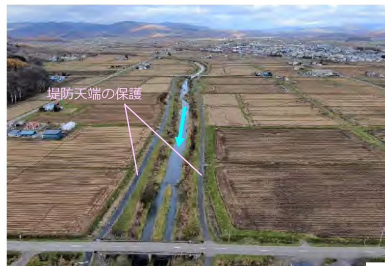
比布川 施工済み箇所
