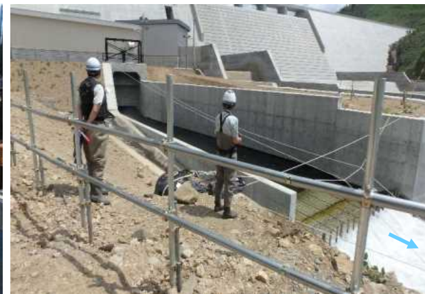
(5/24発電放水路) 流況確認
