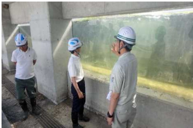
(6/3本川との接続箇所) 観察窓
