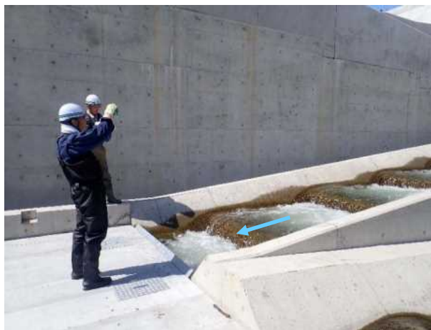
(5/13階段式魚道) 流況確認
