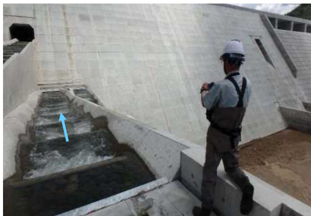
(5/24階段式魚道) 流況確認
