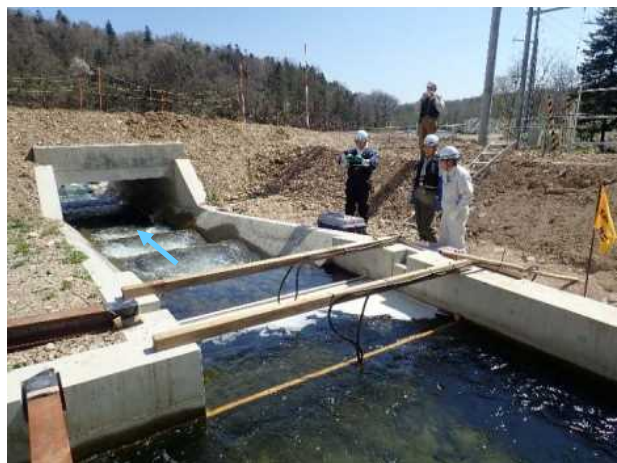
(5/13階段式魚道) 流況確認
