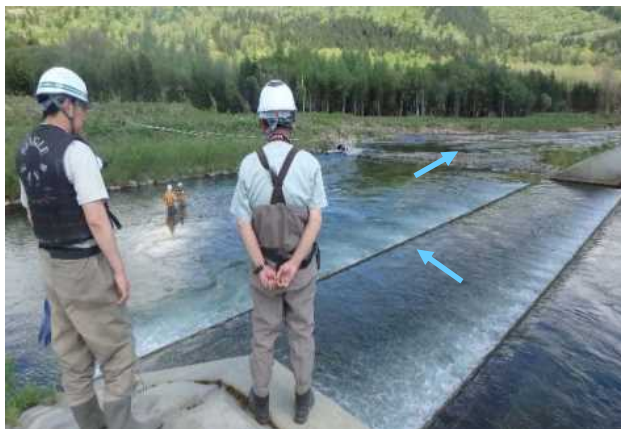
(5/24本川との接続箇所) 流況確認
