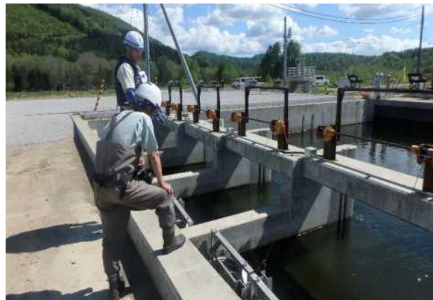
(5/24本川との接続箇所) 流況確認
