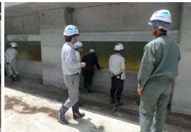
(6/19本川との接続箇所) 観察窓
