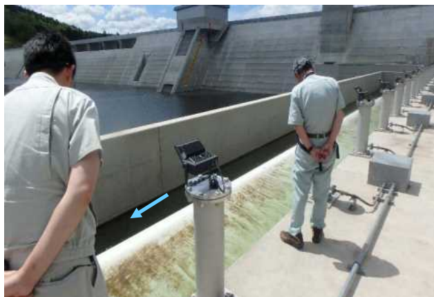
(5/24堤体上流余水) 流況確認
