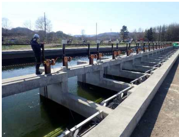
(5/13本川との接続箇所) 流況確認
