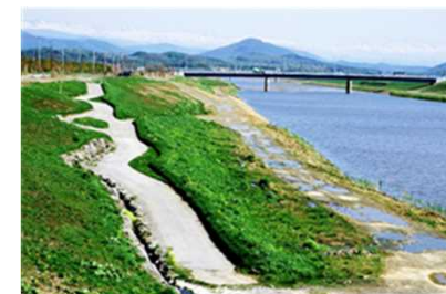
河道掘削(多自然川づくり)
