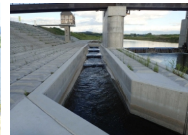
西神楽第1頭首工魚道(旭川市)
