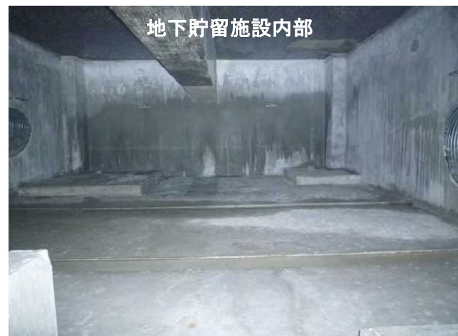
雨水貯留浸透施設の事例【横浜市内】
