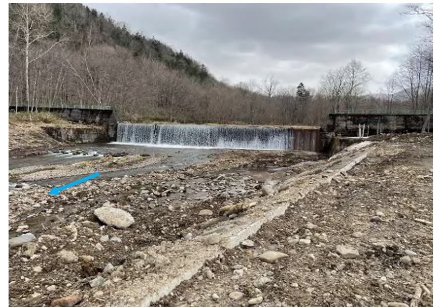
辺別川 施工中箇所(堰堤改良)
