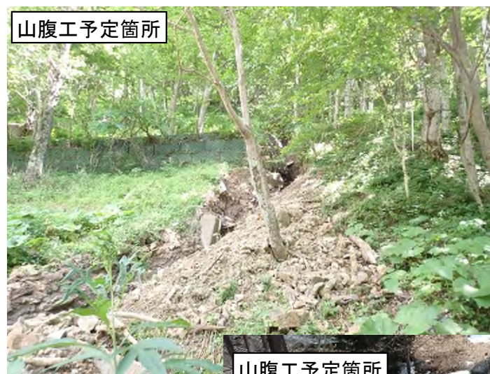
山腹工予定箇所
