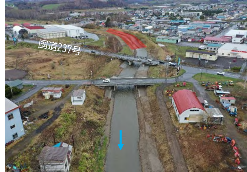
置杵牛川(美瑛町) 施工予定箇所(掘削工・護岸工)
