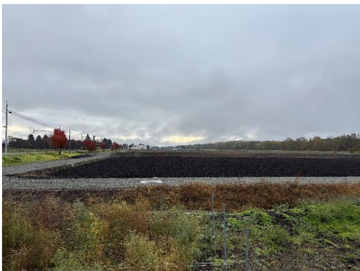
基盤整備工事
