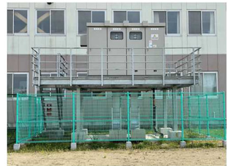
架台の設置による受変電設備への浸水対策
