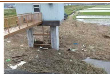
河川管理施設周辺の堆積事例
