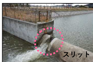
▲スリットの設置状況
