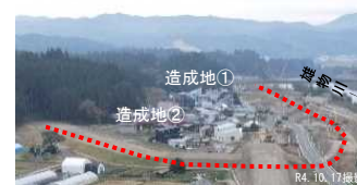
移転家屋の建設が進む状況
