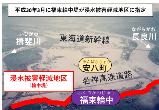
福東輪中堤(昭和51年9月 台風17号浸水時)
