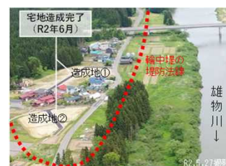
移転先宅地造成完了状況
