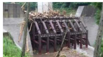
例:透過型砂防堰堤による流木の捕捉
