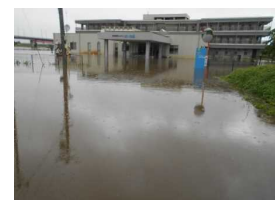
浸水時の状況 (喜多方市提供)
