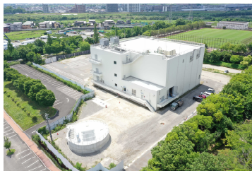
雨水ポンプ場
