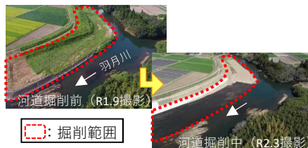
河道掘削(鹿児島県川内川水系羽月川)
