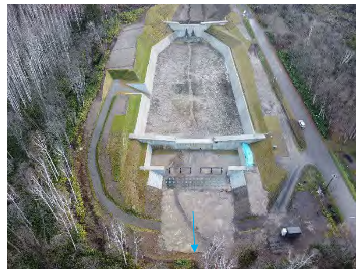
十六線川 施工箇所(砂防)
