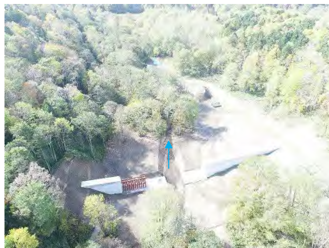
朝日六線川 施工予定箇所(砂防)
