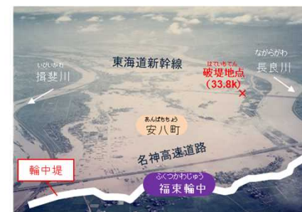
岐阜県輪之内町（福東輪中）
