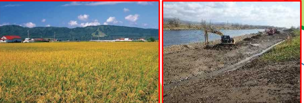
田んぼの雨水貯留機能を活用した洪水氾濫対策（旭川開発開発建設部、上川総合振興局、和寒町等） 天塩川上流の市街地を守る河道掘削（旭川開発開発建設部、上川総合振興局）
