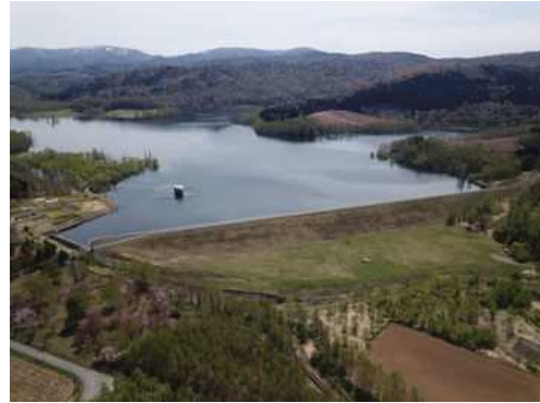
御料ダム (旭川開発建設部、名寄市)
