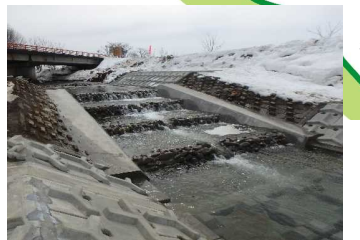
魚類の遡上や産卵環境の保全・再生 (中川町、下川町)
