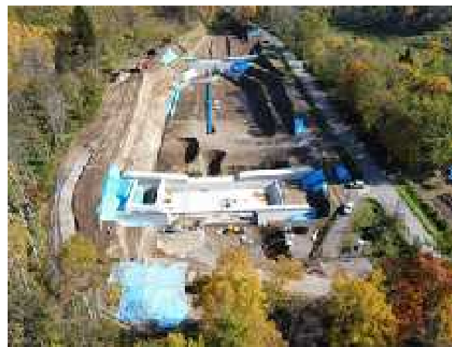
十六線川 施工中箇所(砂防)
