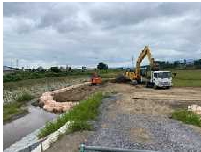
豊栄川 施工中箇所(河川)
