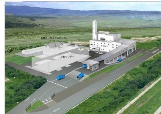
プラットホーム・焼却炉・中央制御室等、設備中枢部は浸水を避けた高さに配置
