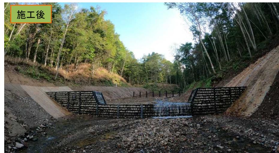
当該箇所は、崩壊土砂流出危険地区のAランクに該当し、下流にある農地及び道道に対し、流木の抑止や土石流の流下を緩やかにすることで被害の軽減を図るため、溪間工と流木捕捉工を各1基設置した。
