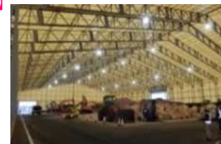
熊本地震時の熊本港における廃棄物仮置
