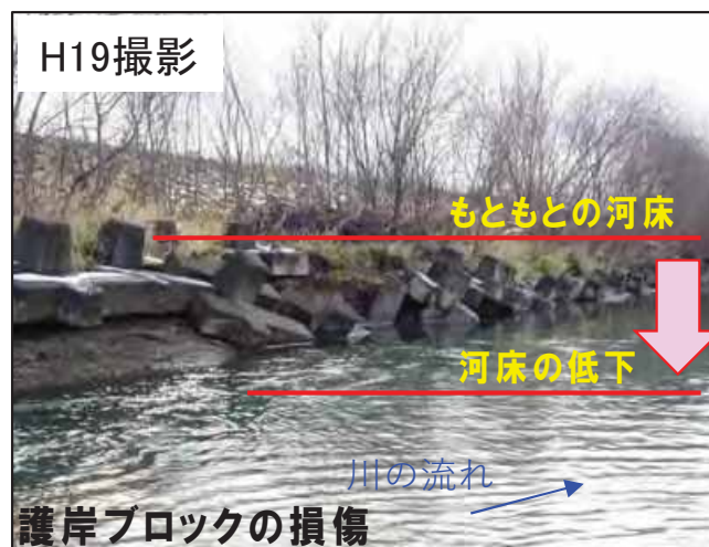
秋月橋下流左岸の状況
