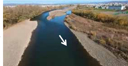
工事後の現在 R04. 10. 31ドローン撮影
