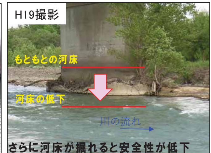
秋月橋左岸橋脚付近の状況
