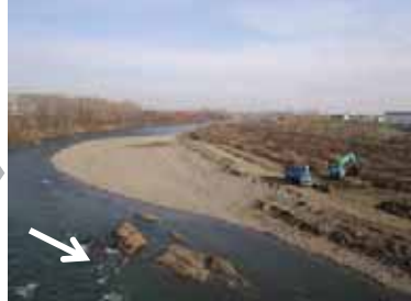
工事中 H26. 11. 12撮影
