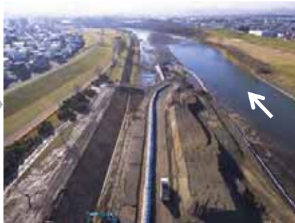
工事中: 締切・覆礫作業中
