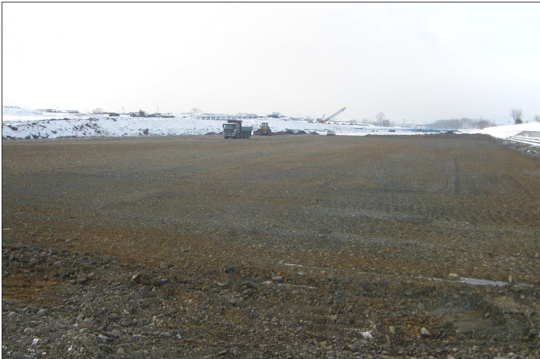
覆礫施工中(H28.1.25撮影)
