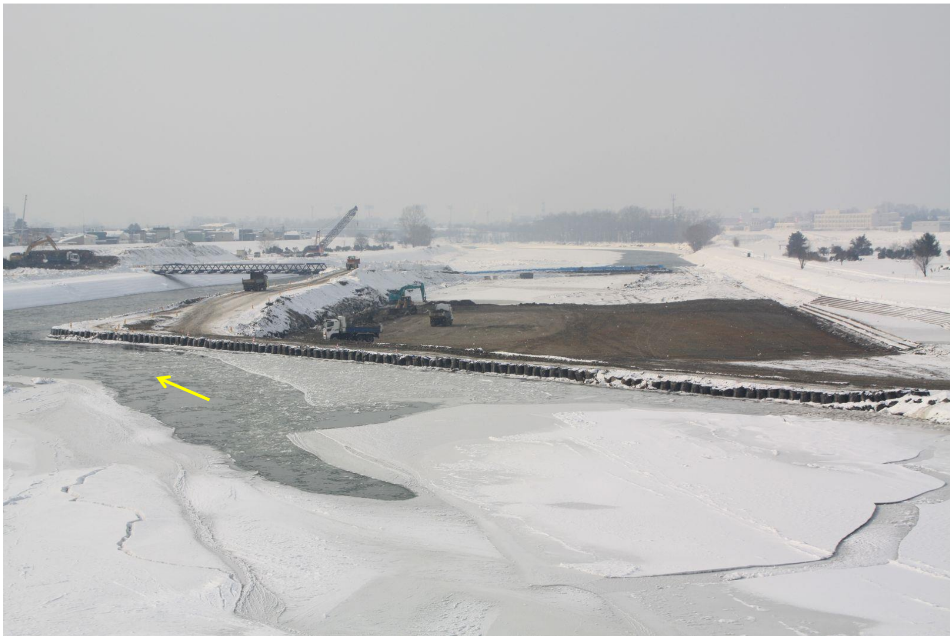
覆礫施工中(28.1.25撮影)
