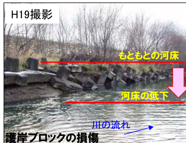
秋月橋下流左岸の状況
