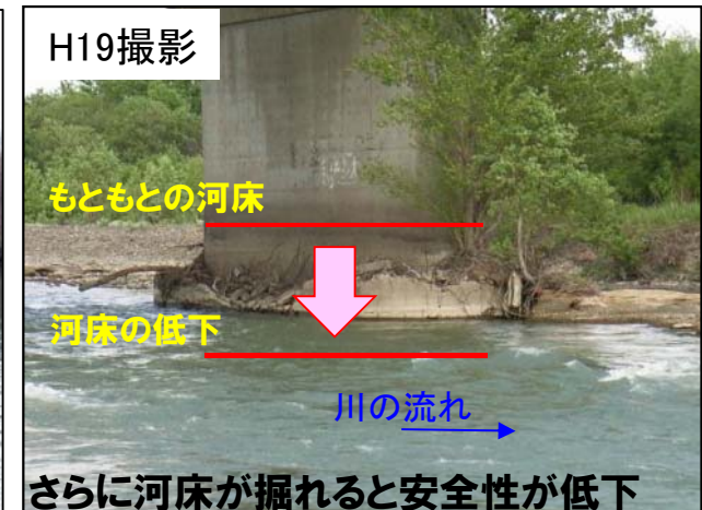
秋月橋左岸橋脚付近の状況
