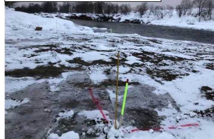
試験施工実施箇所(1月撮影)
