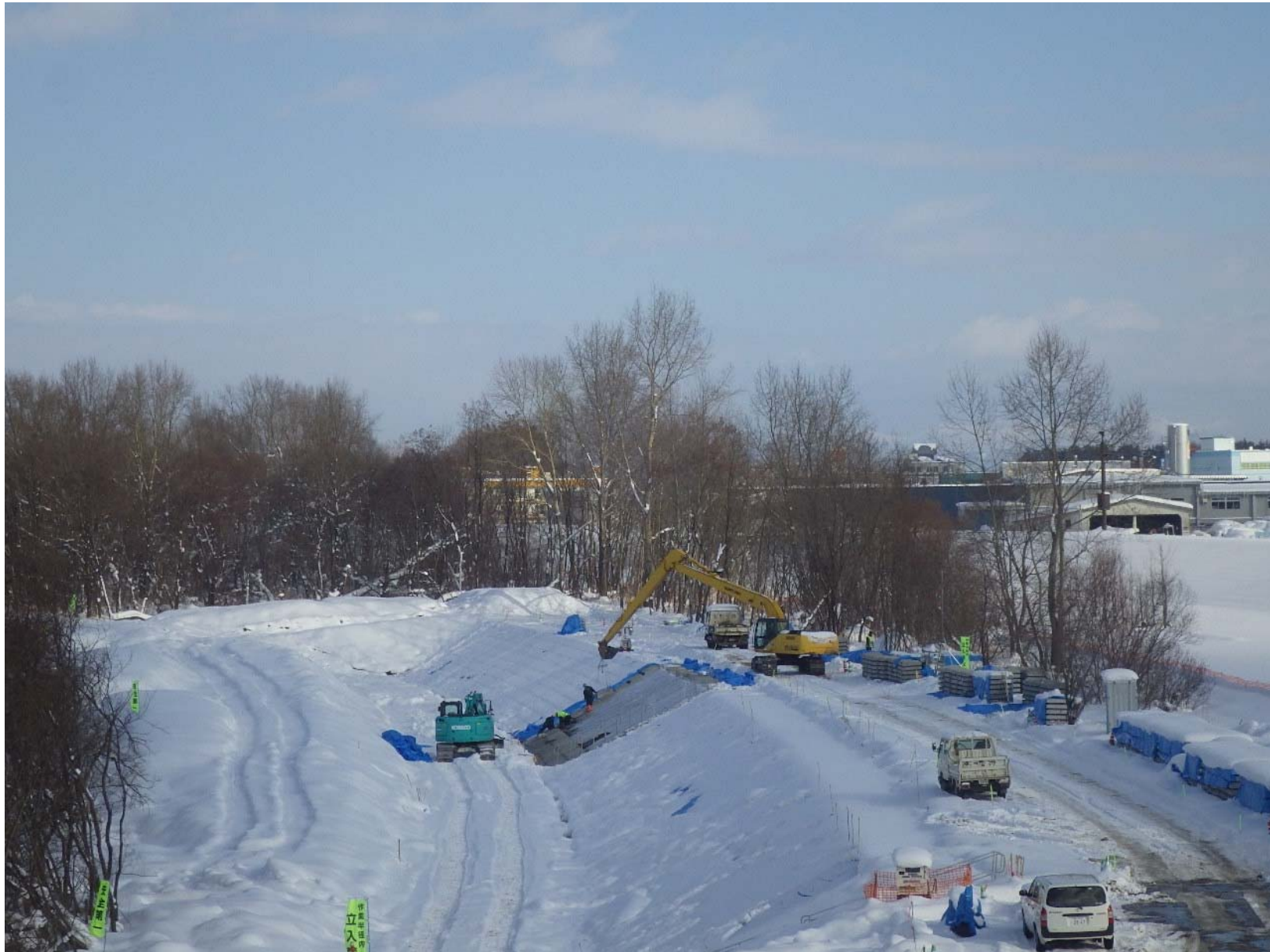
大型連節ブロック敷設状況(H29.12.22撮影)
