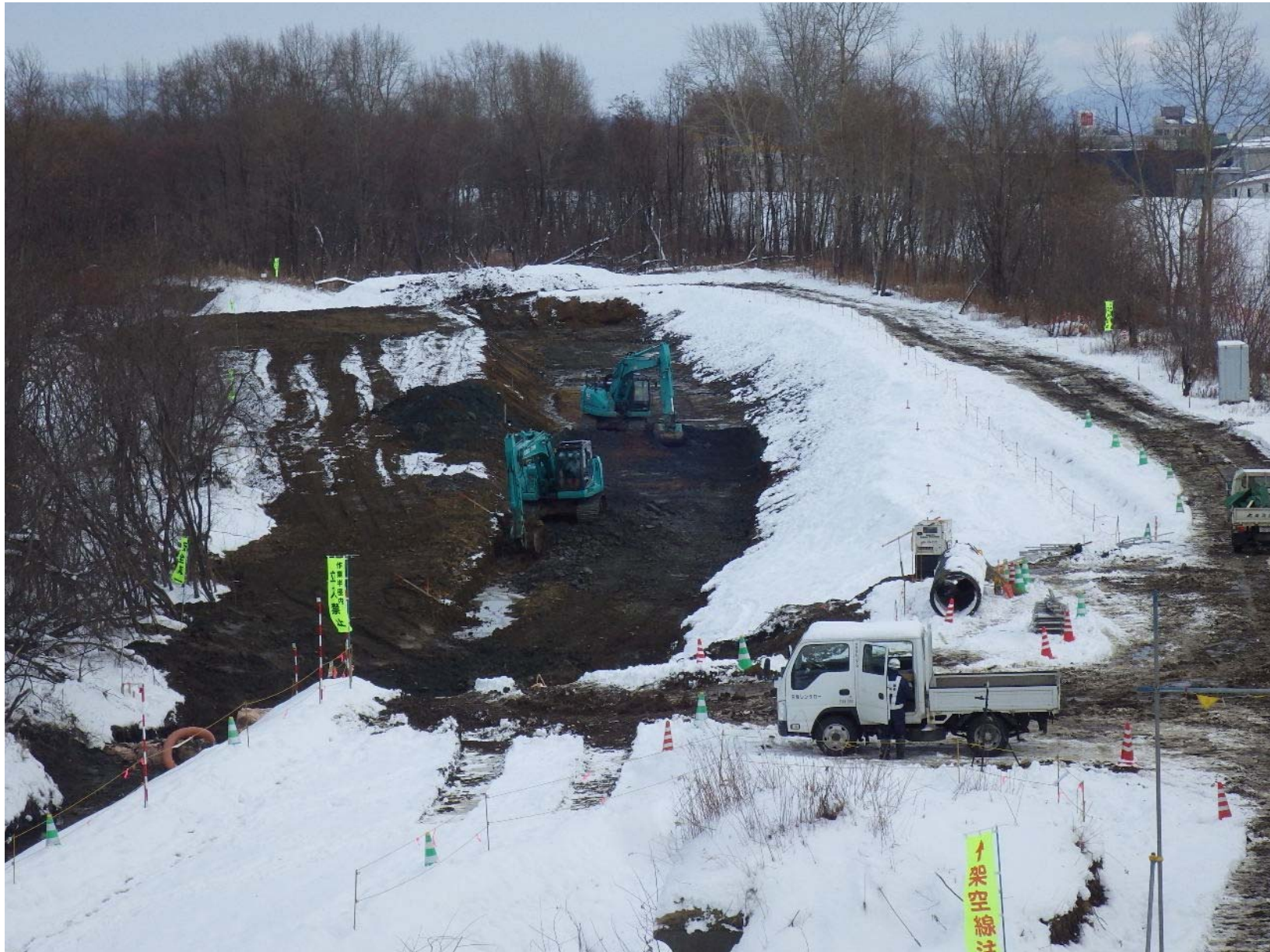
掘削状況(H29.11.22撮影)
