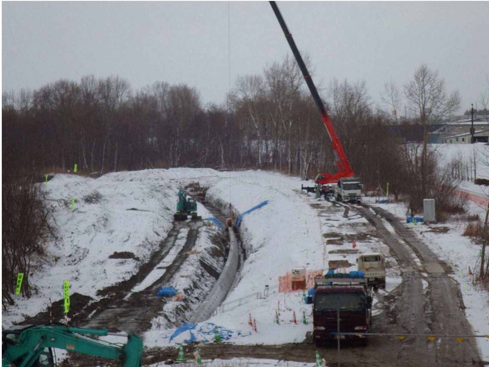
護岸基礎敷設状況(H29.11.30撮影)
