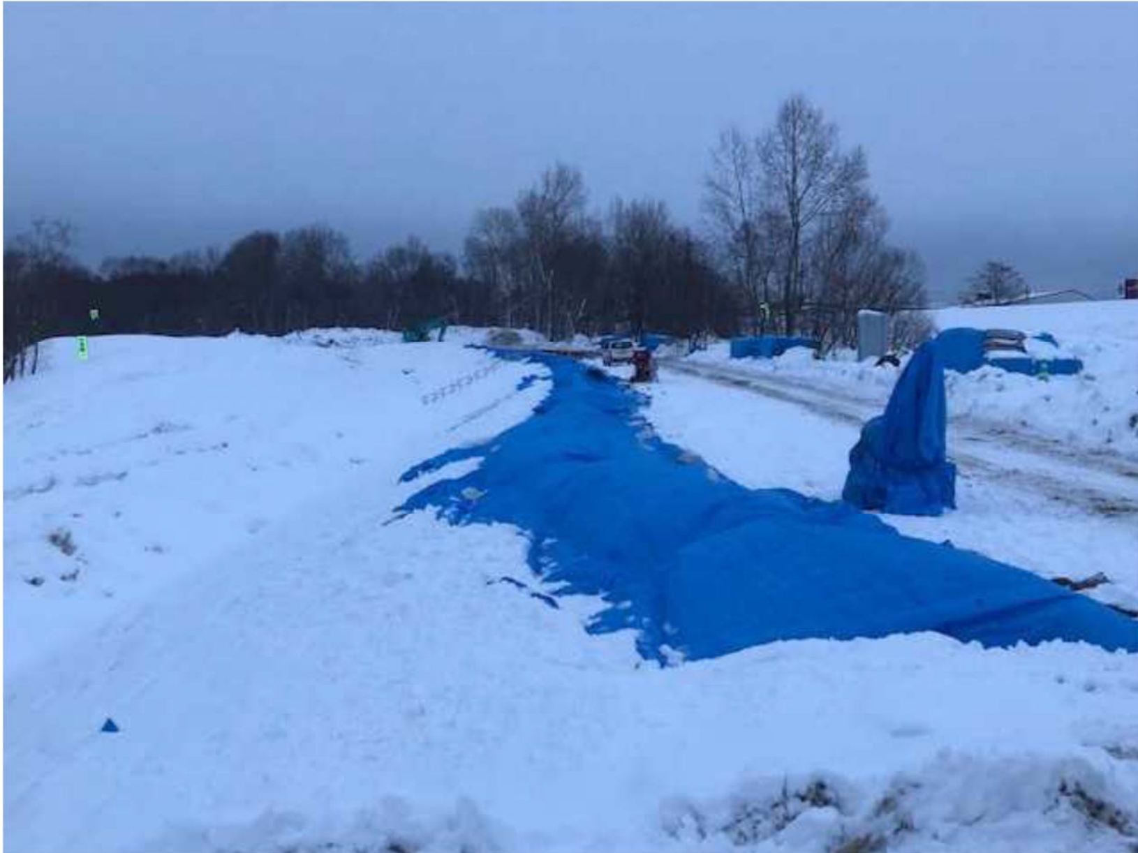
護岸工完了 (H30.1.23撮影)
