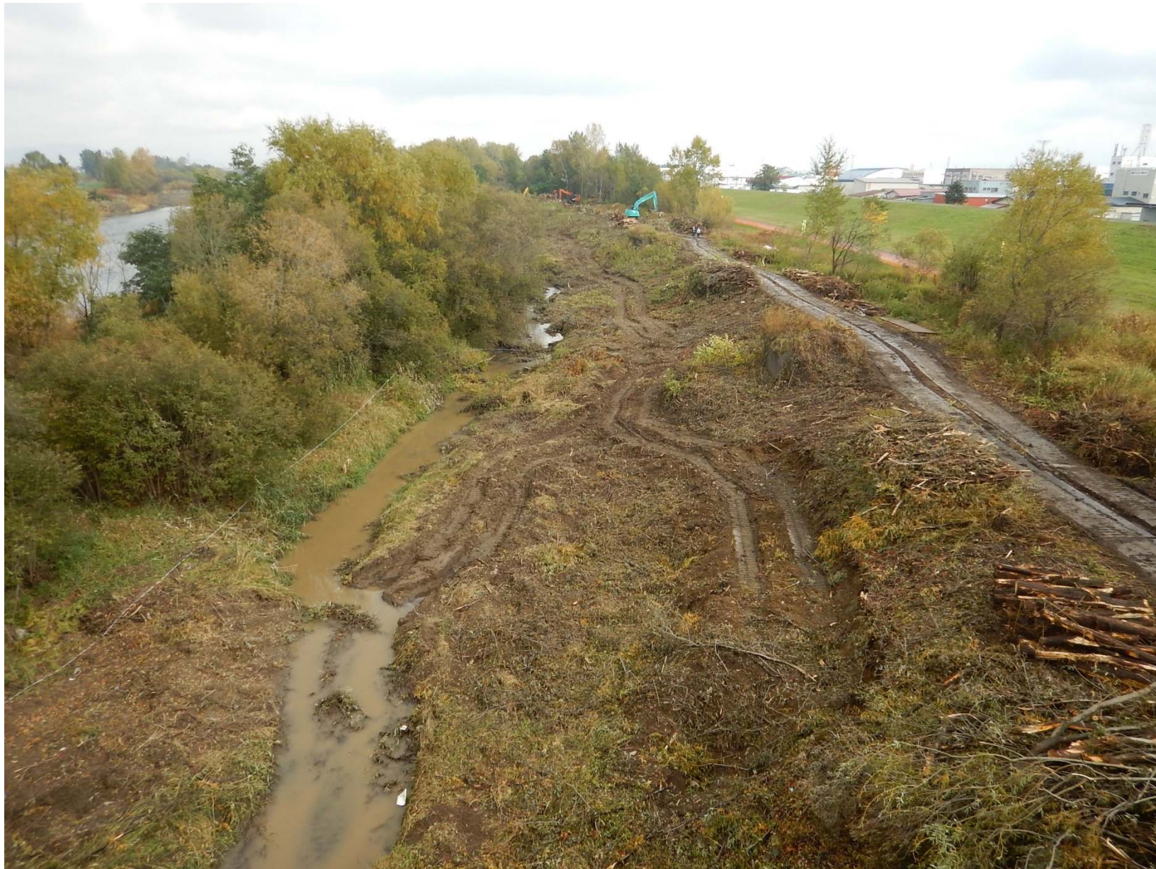
伐開状況(H29.10.18撮影)
