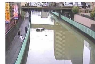
道路の冠水状況
