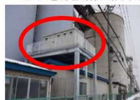
電気系設備の嵩上げ
