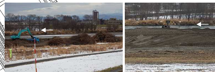
R01施工中(河道掘削)
