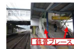
鉄骨ブレースによる駅の耐震補強
