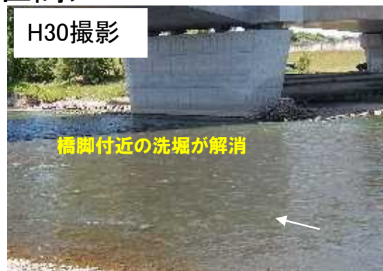
橋脚付近の洗堀が解消
