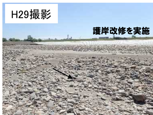
対策工により治水安全度を向上
