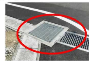
道路上の排水施設
