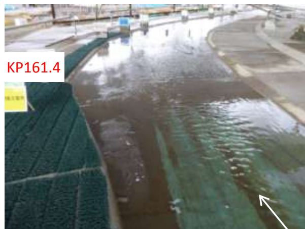
⑦通水4時間後 Q=312.7\text{m}^3/\text{s}
