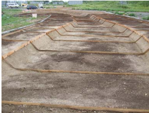
【縦・横断板設置後】
