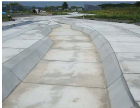
【モルタル河道製作】
