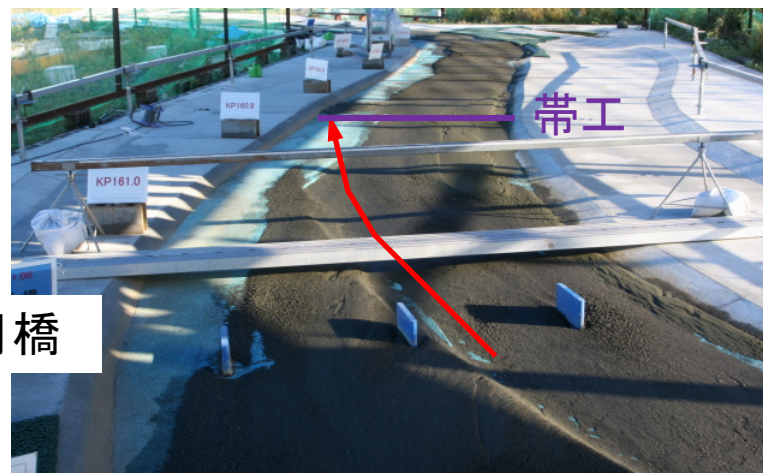
30時間通水後の河床状況 (ケース4-2: 帯工あり)
