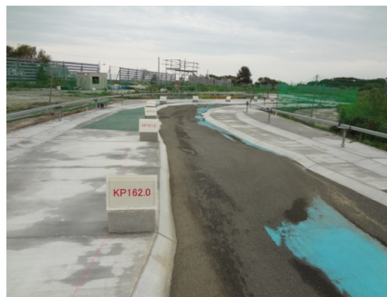
検証実験(1回目)通水後
