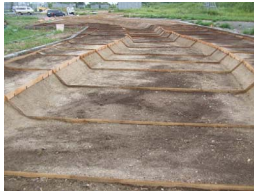
【縦・横断板設置後】
