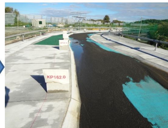
検証実験(2回目)通水後
