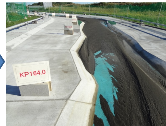
検証実験(2回目)通水後
