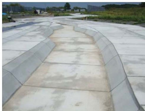
【モルタル河道製作】
