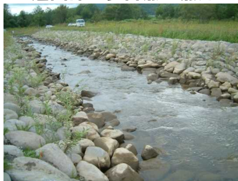
迂回部の多自然型魚道
